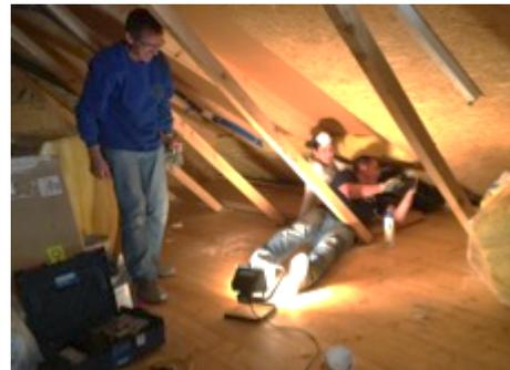
18.06.2016; Unterhaltstag: Montage der Wärmedämmung im Dachgeschoss des JW-Lokals
